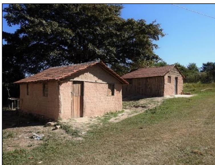
Figura 6.3.234. Casas de Adobe na Comunidade Histórica da Raizinha
